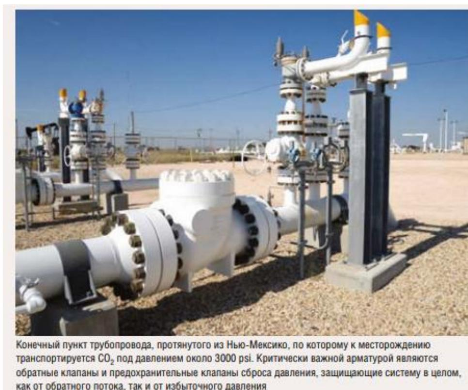
**Рисунок 12- Пример трубопровода протянутого из Нью-Мексико**
